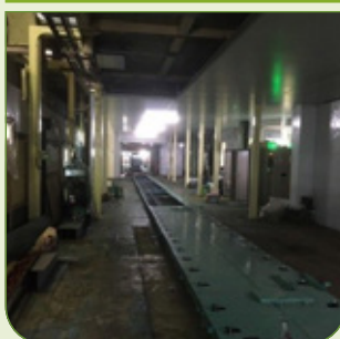
中塗線 A 烤爐拆除
