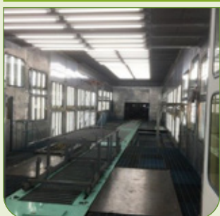
中塗線噴房隔板拆除
