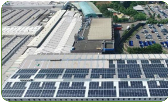
楊梅廠沖壓廠房屋頂太陽能板
